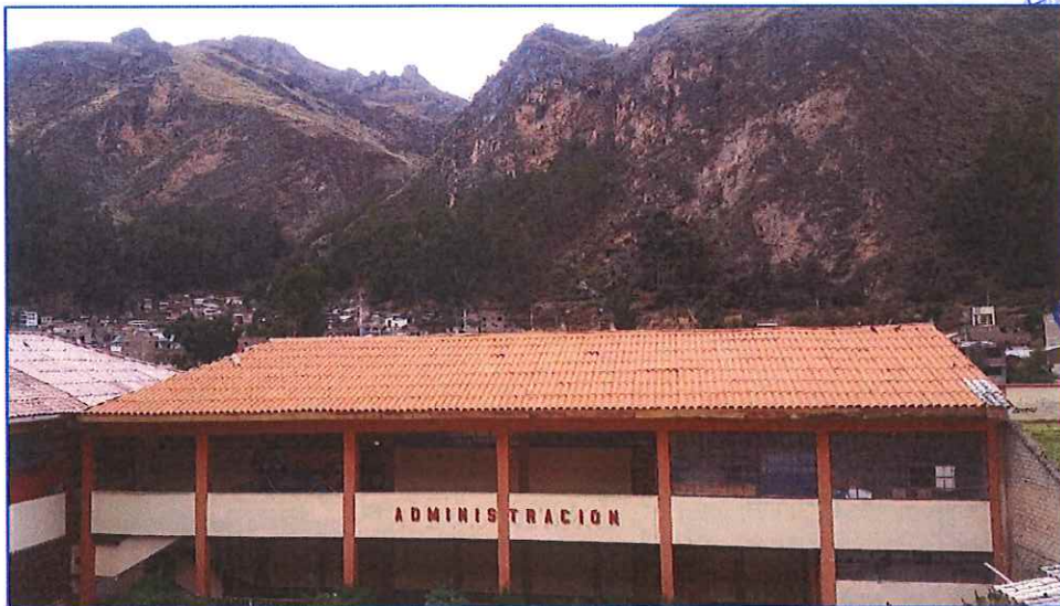
Imagen 04: la cobertura del pabellón se encuentra en mal estado por falta de mantenimiento y por cumplir el tiempo de vida útil; los elementos estructurales y no estructurales del proyecto pueden ser afectados por falta de protección.
