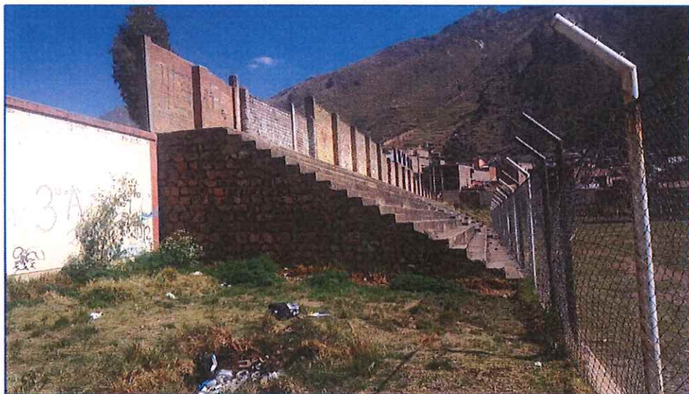
Imagen 08: Se observa la tribuna construida sobre piedras; los cuales podrían generar inestabilidad ante un evento sísmico en la zona.
